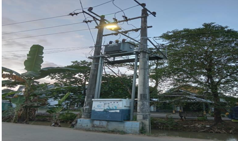
Gbr 2. Contoh Konstruksi Gardu Portal
