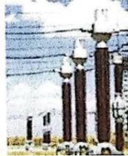
Gambar 2. 6 Trafo Arus Pemasangan Luar Ruangan
