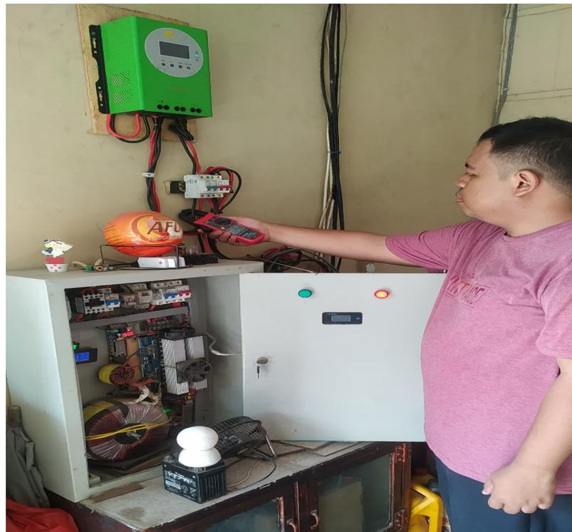
Gambar 4.5 Pengukuran Arus PV
