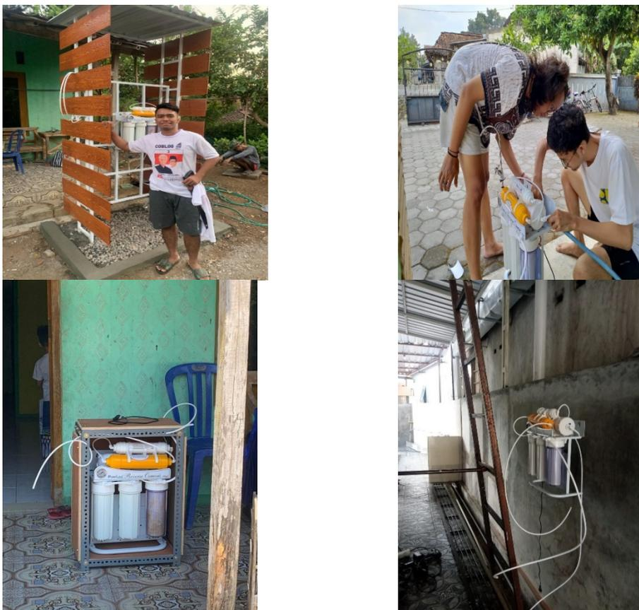
Gambar 1. Pembuatan Instalasi *Reverse Osmosis* (RO)
