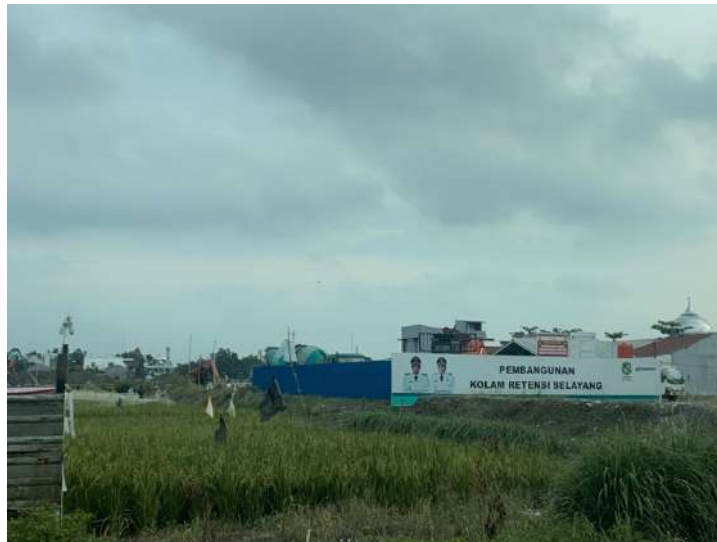
Gambar 1. Pembangunan Kolam Retensi
